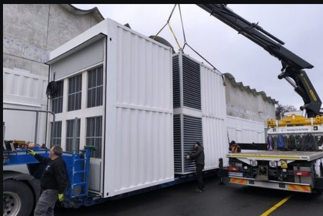
Chargement au camion-grue
