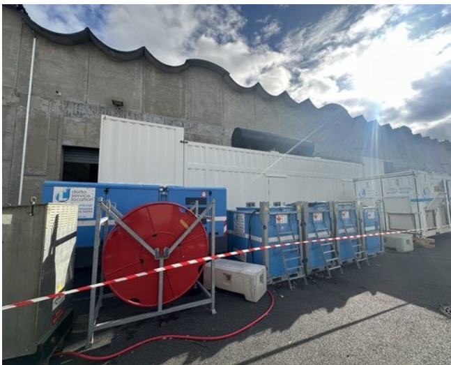
Essais en charge (FAT) avec banc de charge
